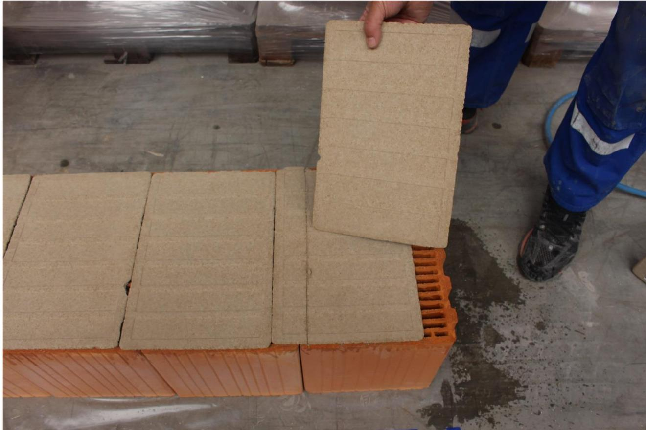
Nehmen Sie ein ganzes Pad und legen Sie es auf das Ende des Mauerwerks. Darunter befindet sich bereits ein weiteres Pad. Verwenden Sie die obere Platte als Schneidlehre.
