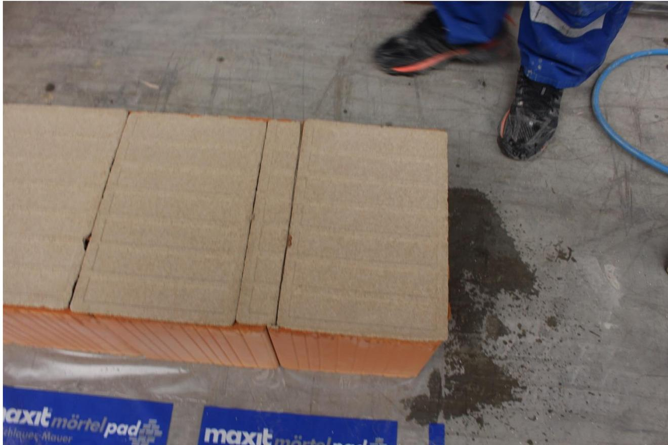
Entfernen Sie nun das untere Pad. Das abgeschnittene Stück verbleibt auf dem Mauerwerk. Die Lücke wird mit einem ganzen Pad belegt.
