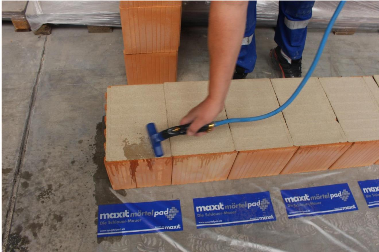
Die Bewässerung erfolgt in Längsrichtung zum Mauerwerk...
