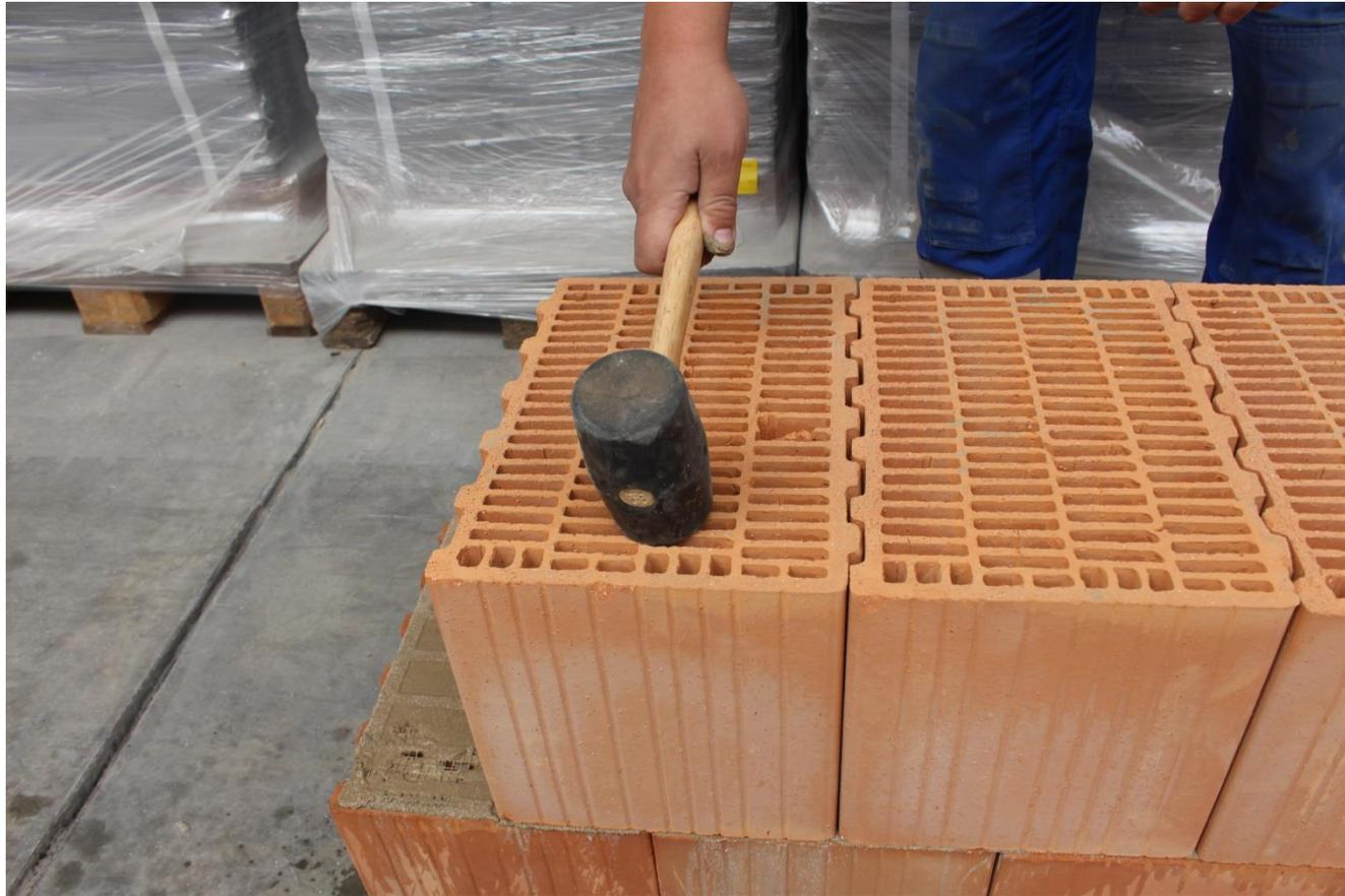
Von besonderer Bedeutung ist auch das Einklopfen des Ziegels in die Mörtelfuge. Der Ziegel muss immer in das Mörtelbett eingearbeitet werden.
