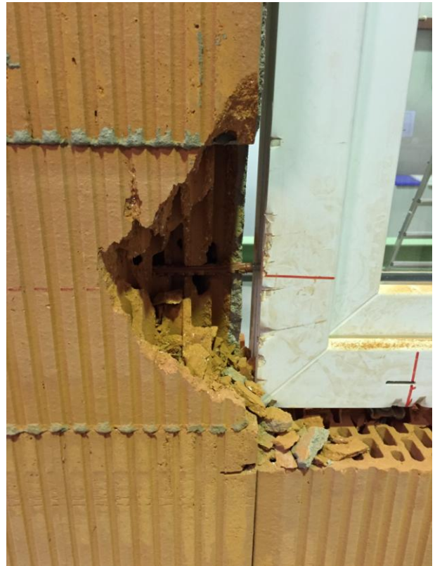
Bild 12: Wandöffnung nach Ende des Einbruchversuchs für die Widerstandsklasse RC2 in PHLzB6 – 0,9 – Wanddicke 240 mm
