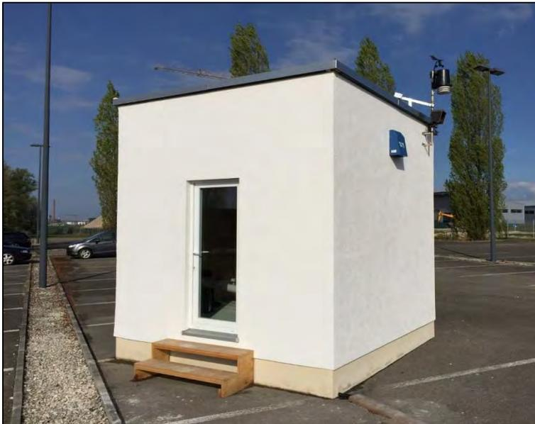
Abbildung 7: Errichteter Brettsperrholzkubus
