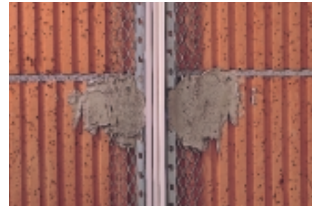
Bild 13 Dehnfugenprofil
