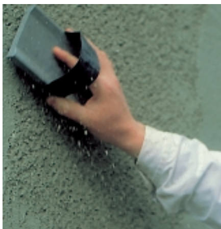
Bild 15 Kratzen des Oberputzes
