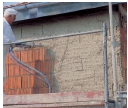
Bild 14 Aufbringen des Unterputzes
