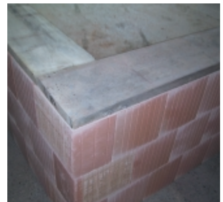
Bild 7 Abdeckung von Mauerkronen mit Dielen
