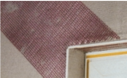
Bild 4 Beispiel einer Diagonalbewehrung
