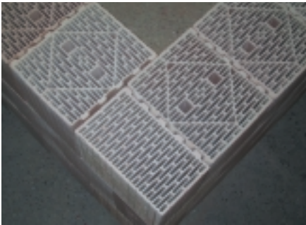
Bild 10 Wandecke mit Eckziegel
