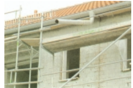
Bild 6 Ableitung von Dachflächenwasser
