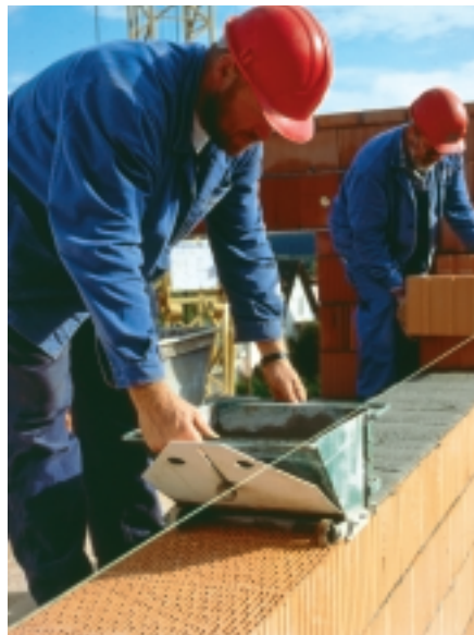
Bild 8 Vollflächiger Mörtelauftrag
